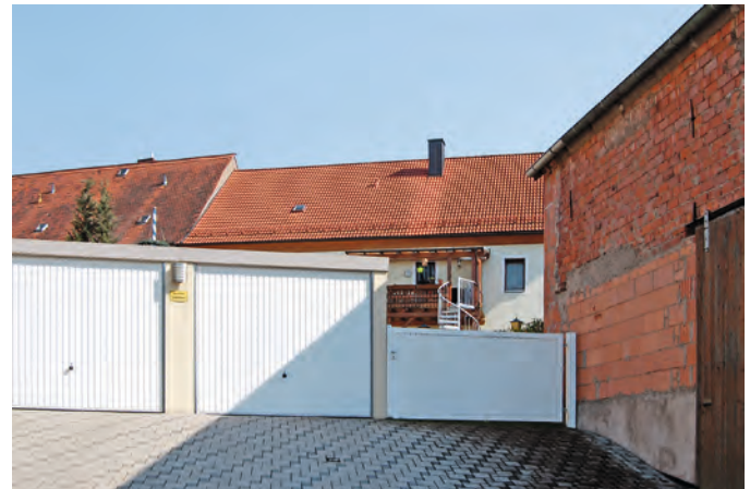
Abb. 12. Marktplatz 18. Die Fertiggaragen sind nach dem Abbruch einer Scheune entstanden. Die geschlossene Wirkung der Hofanlage ist damit verloren gegangen (Foto: ARGE transform und Klaus Herta)
