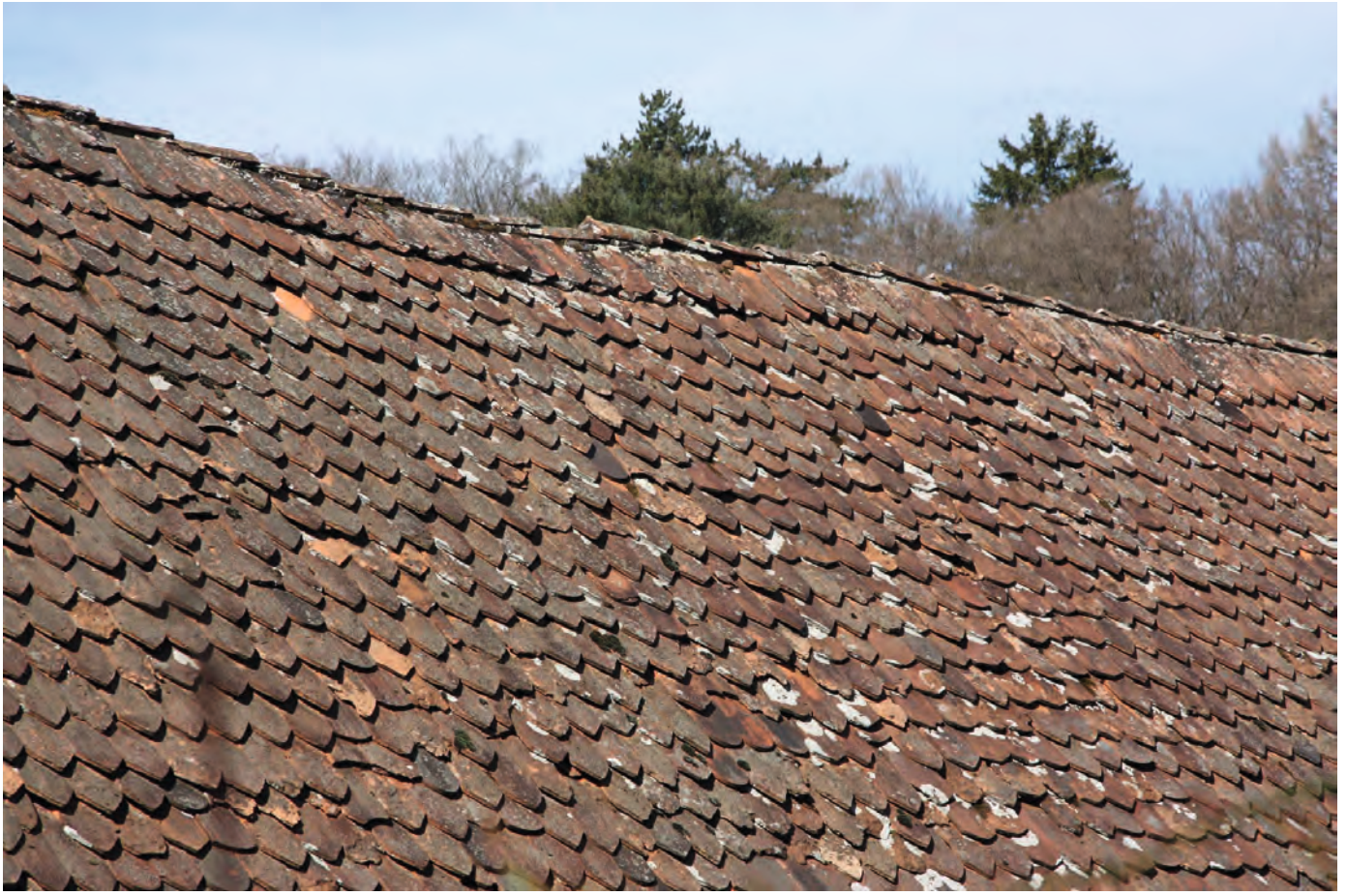
Gräfenberg, Scheunenviertel (Foto: Christiane Reichert, Kunst & Denkmalpflege, Bamberg)
