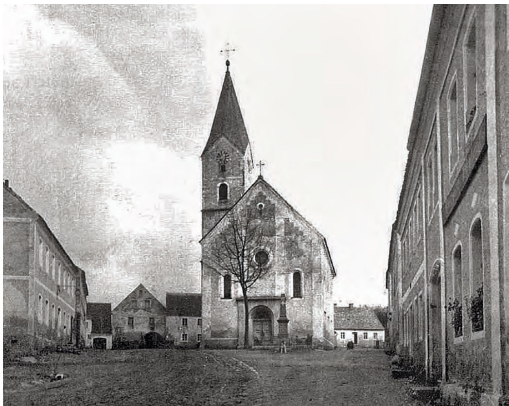
Abb. 5. Fotografie des Marktplatzes um 1900 mit den zurückversetzten Bauten (Privatbesitz Max Griesmeier/Franz Bergler, publiziert in: BERGLER, FRANZ: Waldthurn in alten Bildern , Weiden 1981)
